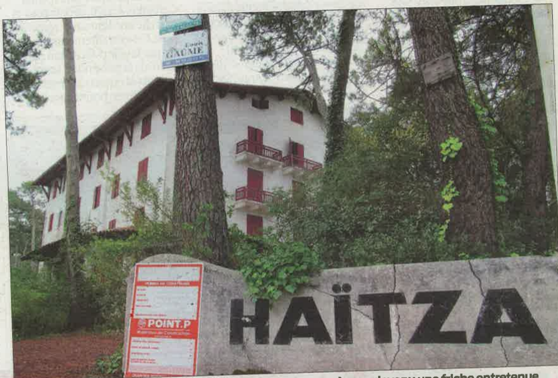
Depuis 2002, l'Hôtel Haïtza a fermé ses portes et est, peu à peu, devenu une friche entretenue pour ne pas partir à l'abandon. PHOTO D.P.
