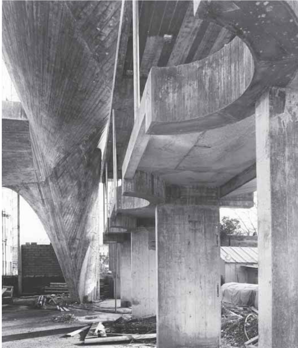
Le chantier du hall des véhicules: les façades sont désolidarisées de la structure.
